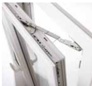
DÉTAIL SYSTÈME OSCILLO-BATTANT
