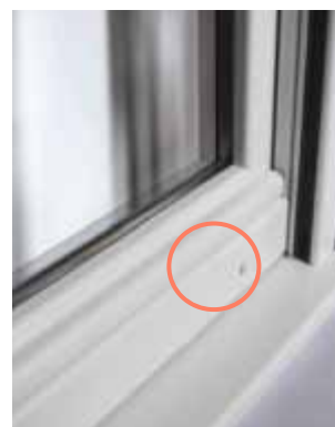
JET D'EAU EN OPTION, AMÉLIORE L'ÉTANCHÉITÉ
